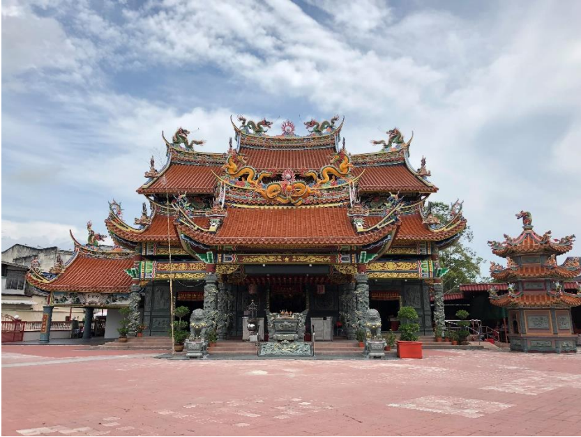
图 1：新兴港噬啁公庙外观
